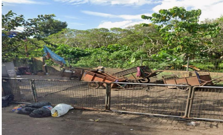
Gambar 5. Jalan dan Drainase
